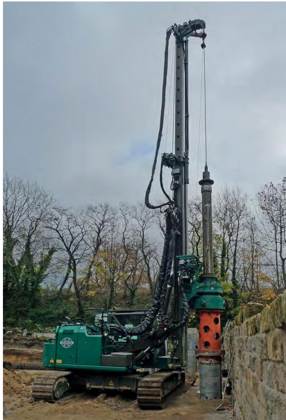
Abbildung 2: Beispielhafte Darstellung einer Drehbohranlage. Der benötigte Arbeitsbereich entspricht der schematischen Darstellung in Abbildung 1
